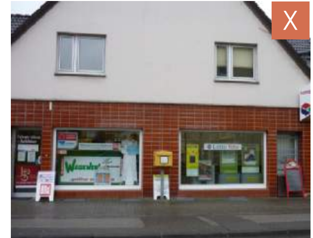
Abbildung 78: Große ungenutzte Fensterflächen ohne Bezug zur Gebäudearchitektur.
