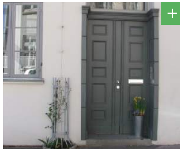
Abbildung 88: Rankhilfen lenken die Wuchsrichtung der Fassadenbegrünung.
