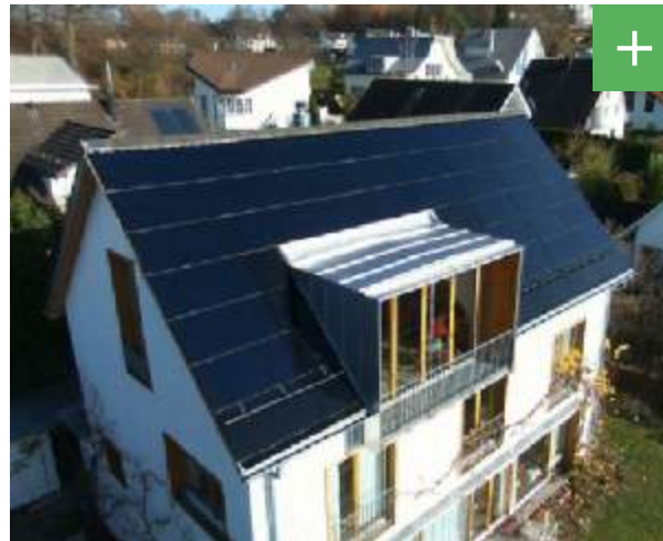
Abbildung 46: Einbau der Solaranlagen in dunklen Farben in die Dachhaut.
