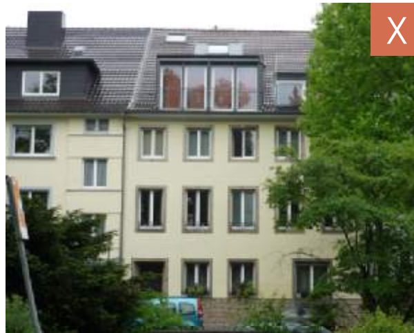
Abbildung 42: Maßstabsbruch zwischen Dachaufbauten und Fassade.
