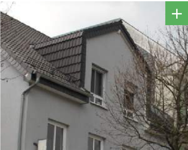
Abbildung 40: Moderner Zwerchgiebel, der sich in Dachform und Dachmaterial integriert.
