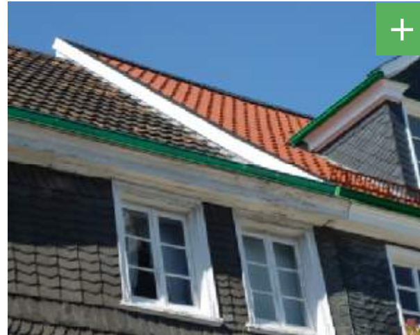
Abbildung 24: Beispiel für eine gelungene Aufdachdämmung (Farbton hier nicht angepasst).
