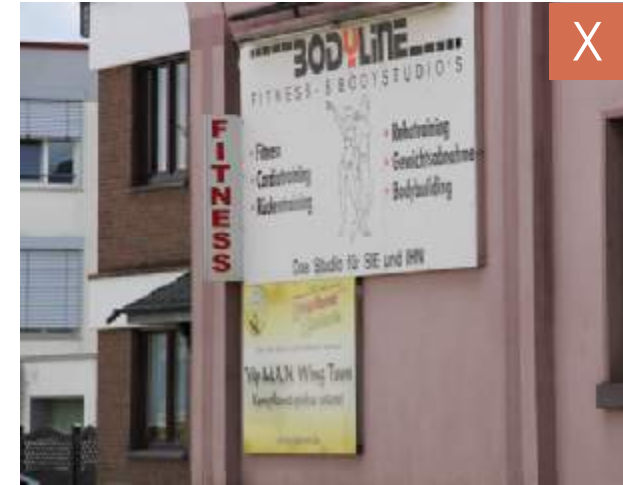
Abbildung 104: Überdimensionierte Hinweisschilder ohne Fassadenbezug.
