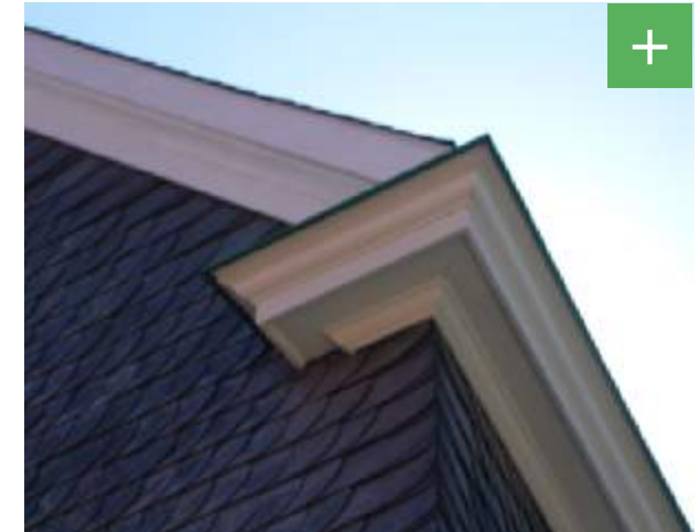
Abbildung 26: Unauffällige Aufdachdämmung unter Berücksichtigung der Gesimse.
